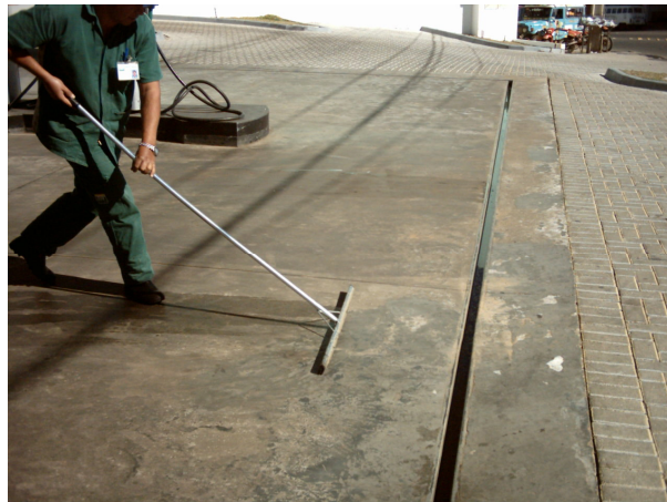
Figura nº 6 - Canaleta de contenção
