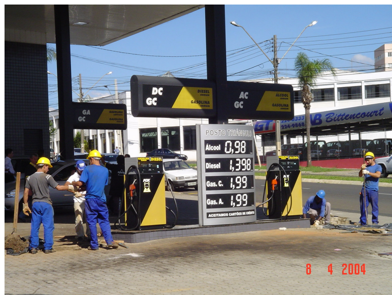
Figura nº 23 - Investigação de passivos ambientais
