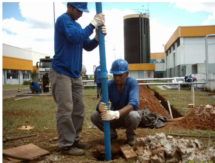
Figura nº 3 – Instalação de poço de monitoramento
