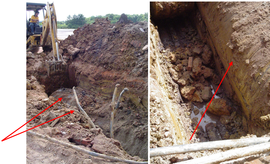
Figura nº 22 - Retirada de SASC
