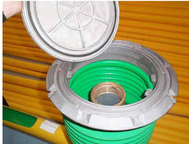
Figura nº 10 - Câmara de contenção da descarga selada
